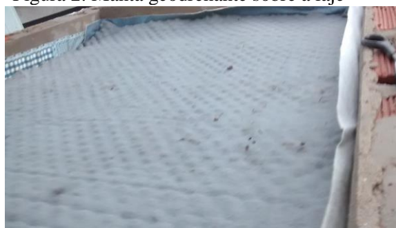
Figura 2: Manta geodrenante sobre a laje
